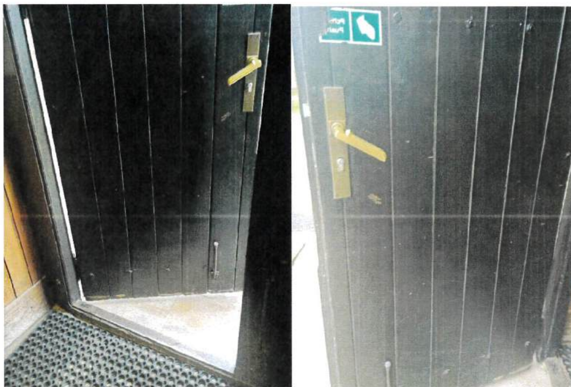
Mikuszowice kościół p. w. Św. Jana Chrzciciela - istniejący stan techniczny drzwi - strona wewnętrzna
