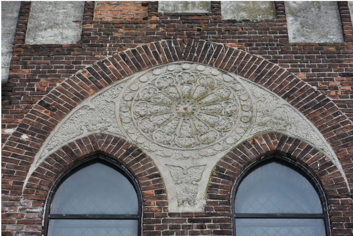
Fot.20. Motyw dekoracyjny na ścianie szczytowej transeptu od strony południowej. Widoczna korozja biologiczna i nieliczne ubytki
