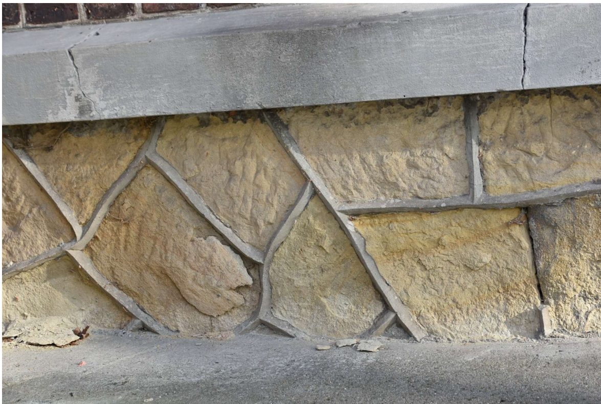
Fot.6. Rozwarstwiające się i zmurszałe fragmenty ciosów podmurówki
