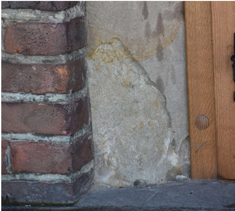
Fot.22. Rozwarstwiony dolny fragment jednego z kamiennych portali
