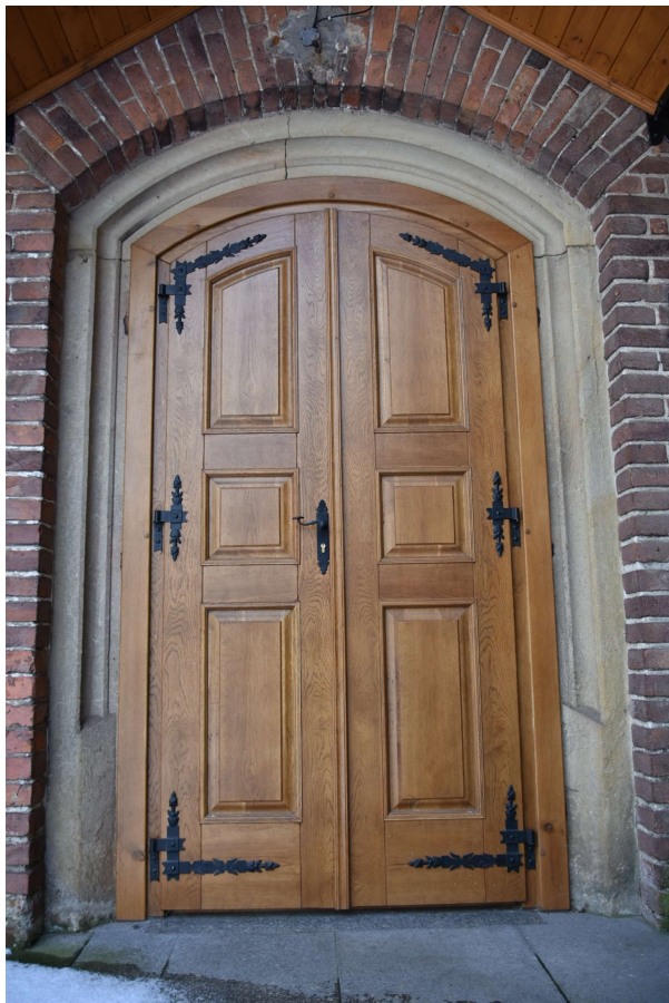
Fot.23. Odtworzona na wzór oryginalnej stolarka drzwiowa
